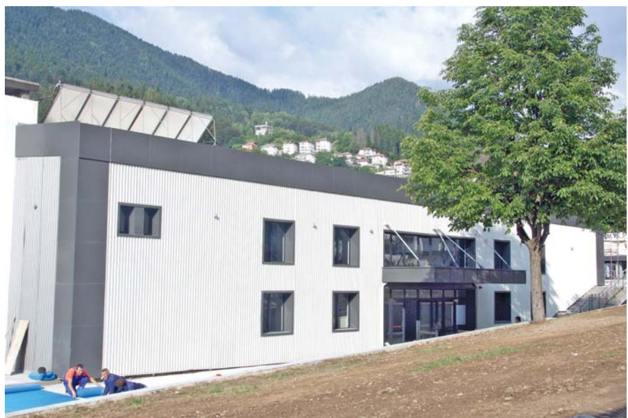
Последни довършителни работи по ремонта на басейна.
